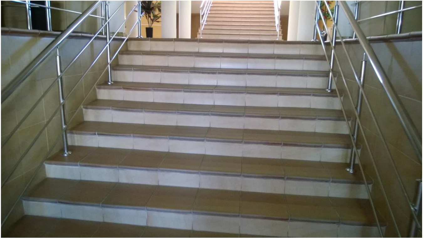
фото 9. «Лестница внутри здания»
