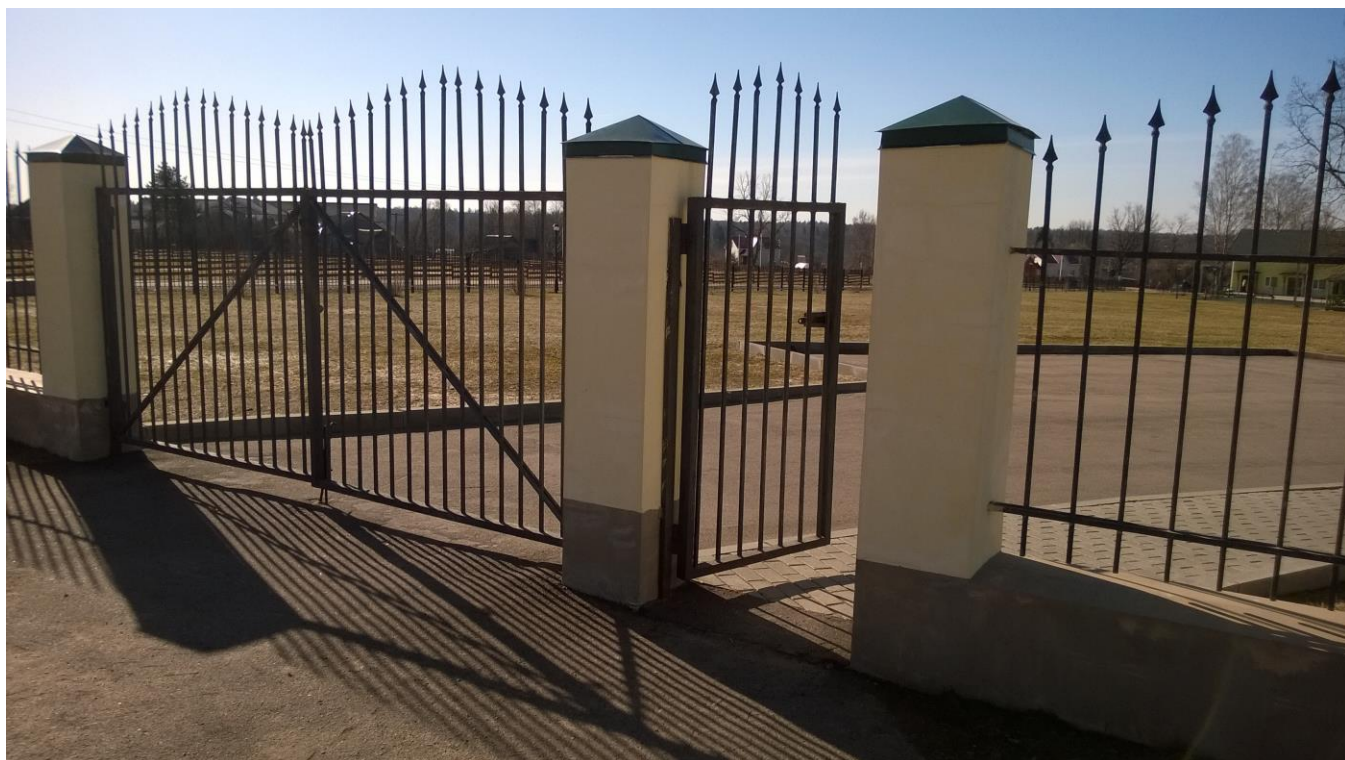
фото 1. «Вход на территорию учреждения»
