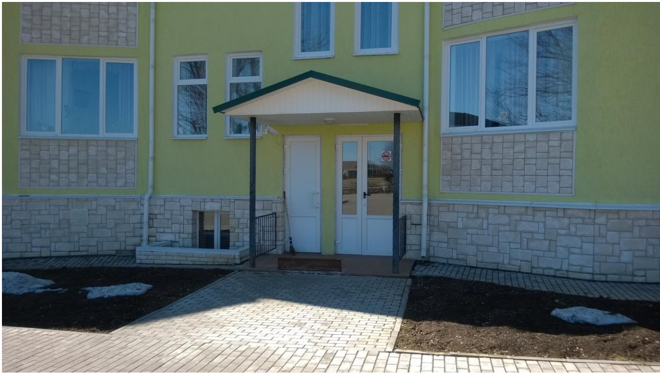
фото 7.» Входная дверь «запасного входа»
